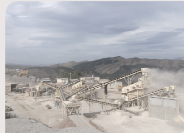
340 t/h Sand Plant, Sétif, Algeria
